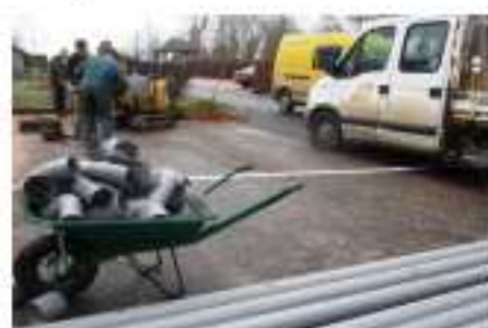
Canalisation des eaux de pluie vers la salle polyvalente
